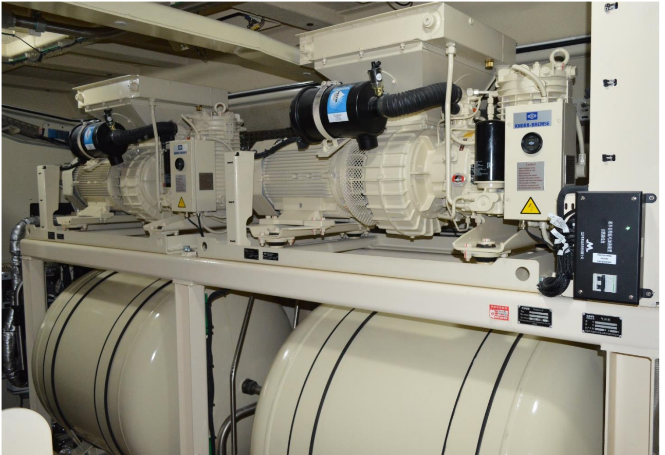
Рисунок 27 – Общий вид блока мотор-компрессора
