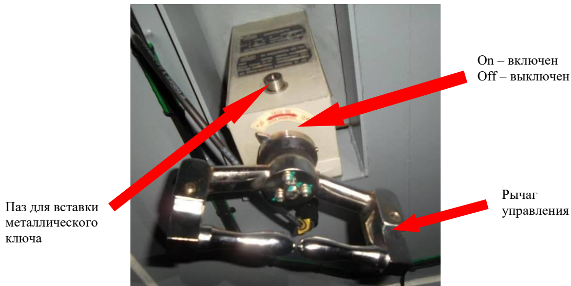
Рисунок 19.8 – Высоковольтный разъединитель QS-HV
